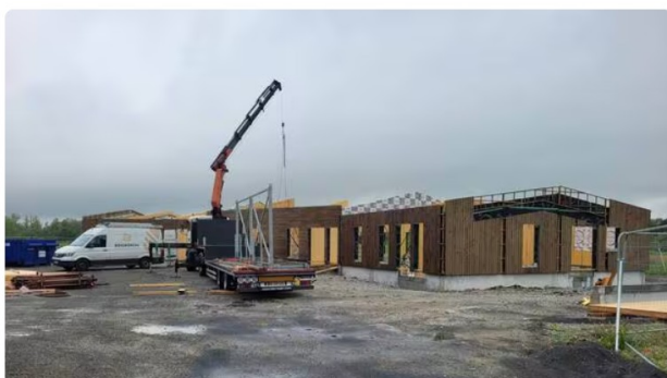
La construction des nouveaux bâtiments de services d'aide à domicile va bon train et leur réception est espérée avant fin 2026. | OUEST-FRANCE
